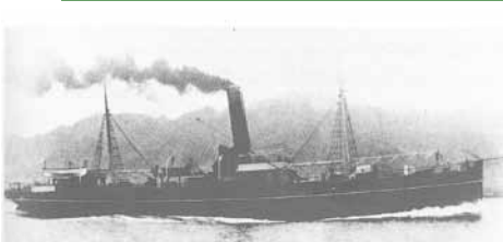
【写真説明】：ピアソン夫妻が小樽から乗った船の釧路丸。明治36年新造。 67.06 × 8.84 × 6.92 m. 1,076GT、107HP、12.96KT。 1944年11月に九州の枕崎で沈没。
